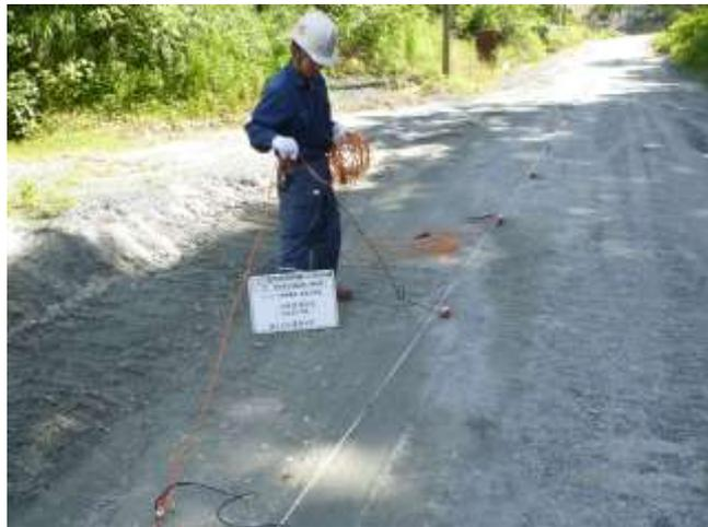
リニアアレイ微動探査・表面波探査 堤体軸直交測線 2m 間隔測線展開状況
