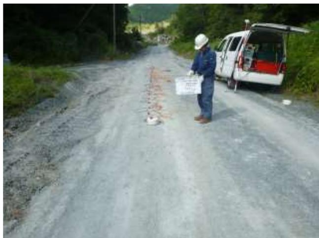
リニアアレイ微動探査・表面波探査 堤体軸直交測線 0.5m 間隔測線展開状況
