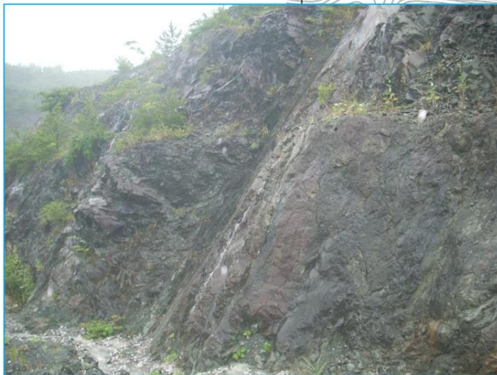
本図は、雨の後を示したものであるが、割れ目系に沿って流水が生じていることがわかる。これらの流水には、茶褐色の細粒土砂（粘土分多）が混入しており、割れ目面に付着することがある。こうした流水が生じる環境にあるので、割れ目系に沿って土砂が溜まる。なお、最終処分場の設置にあたっては、こうした流水を排除するための集排水施設を適切に設置することになるが、これにより、埋立廃棄物内への流水の侵入を防ぐだけでなく、斜面の劣化を防止でき、斜面の力学的安定性にも寄与することとなる。
