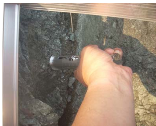
中央部の状況
