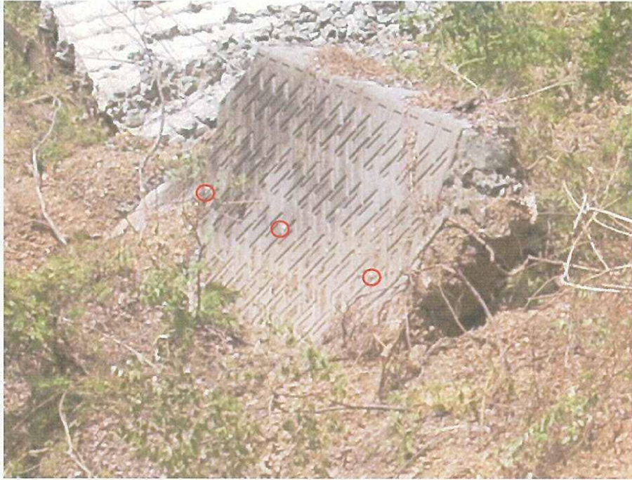
写真-7 コンクリート間知擁壁の排水孔
