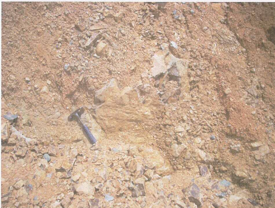
写真-6 流出土砂と土砂による浸食
