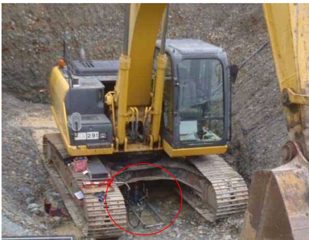
写真 2-2-2-1 屋外型の平板載荷試験の状況例（赤枠内が試験装置）
