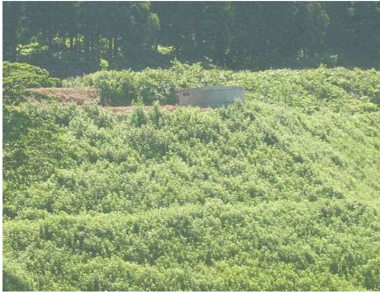
写真 4-3-2-2 埋立終了後の廃棄物層内の集排水能力を向上させるために設けられた集水井の例
